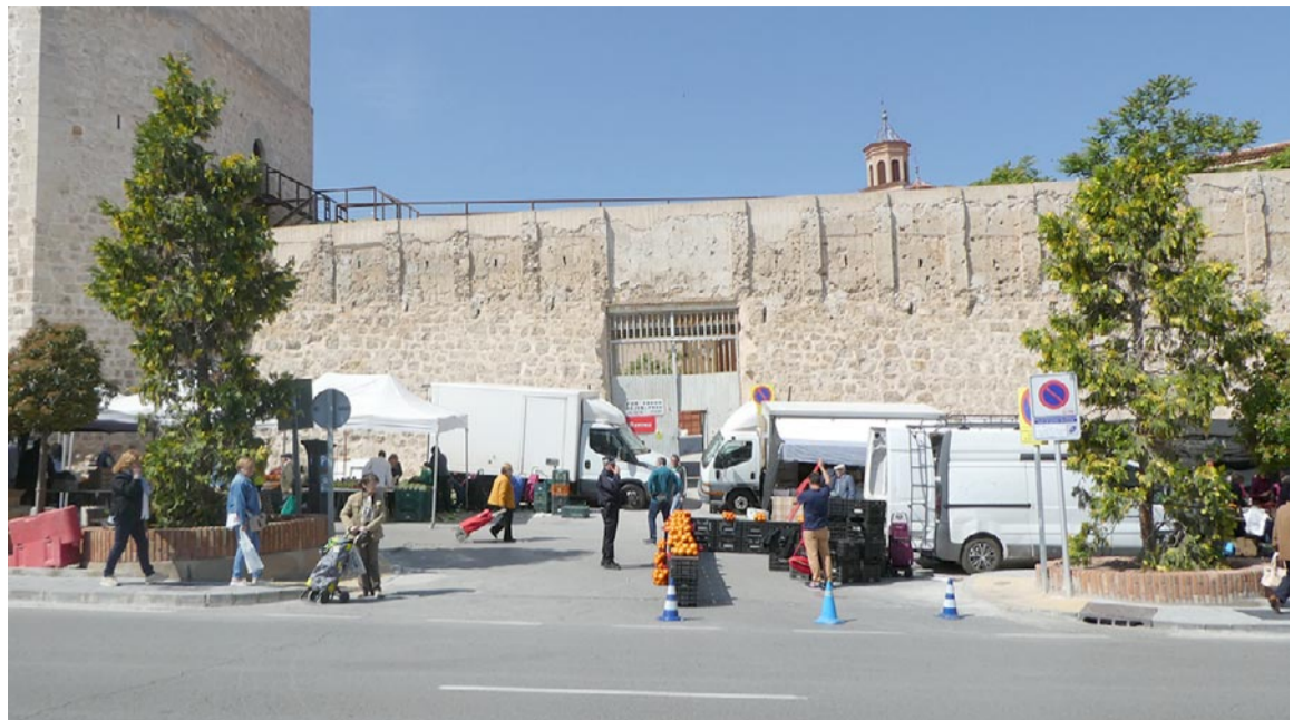
El tapial de la muralla medieval de Teruel tendrá continuidad y el vano existente se tendrá que tapiar
