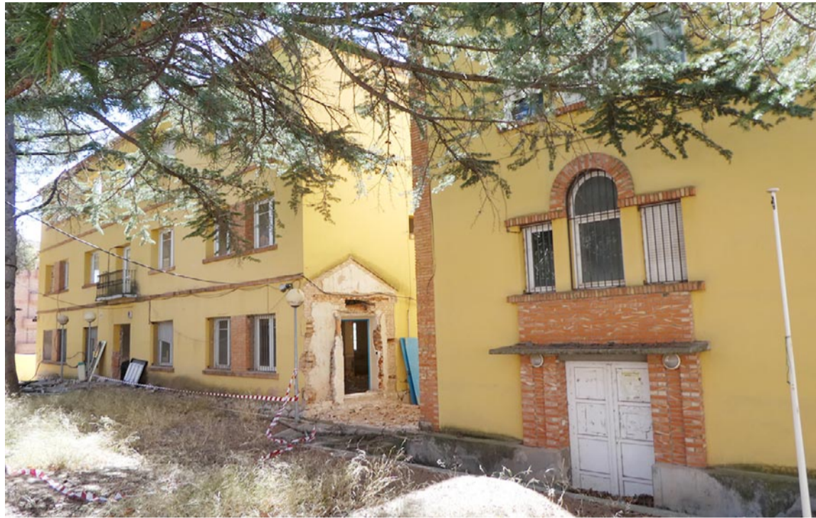
Estado de los trabajos que se están haciendo en el edificio que albergará el nuevo centro sociocultural de San León
