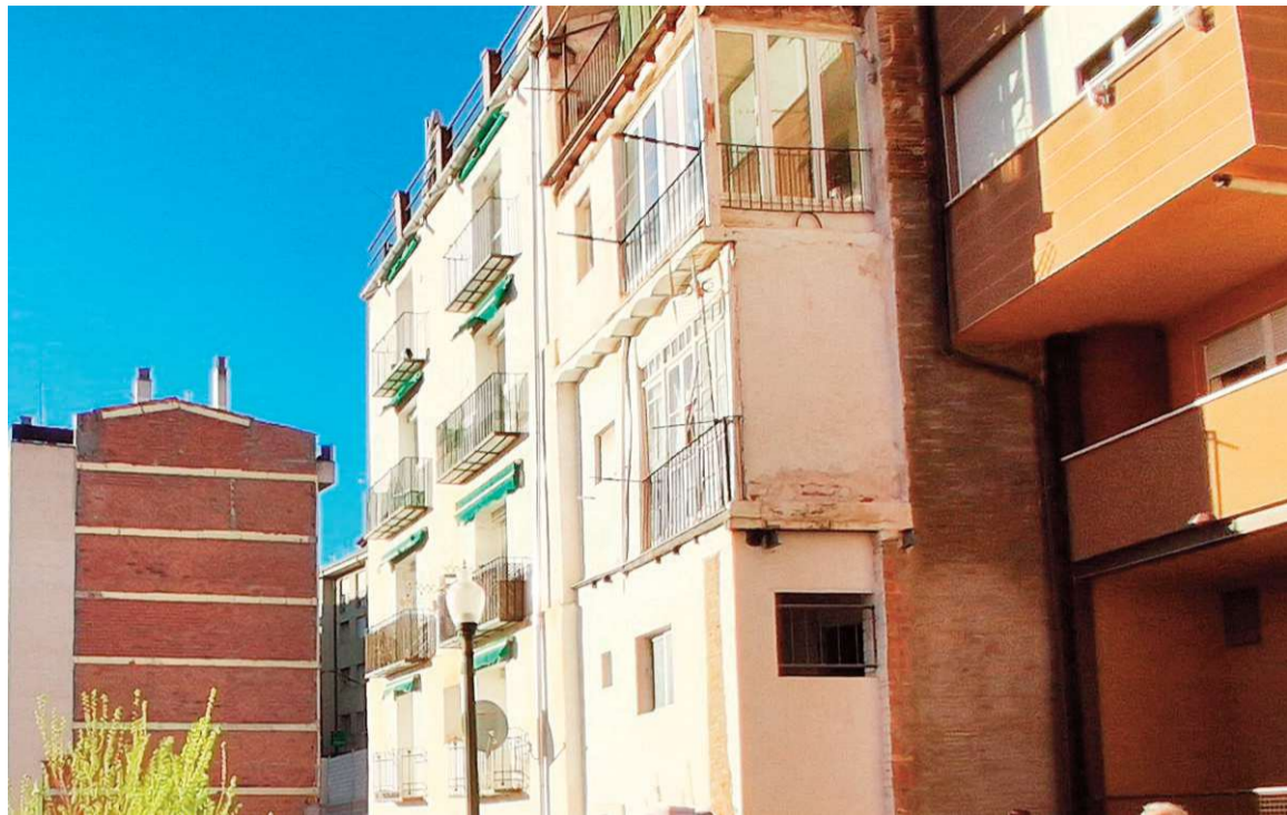
Parte trasera de los números 19 y 17 de la calle San Francisco, que tienen que ser derribadas
