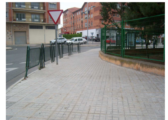
Valla de cerramiento del IES
